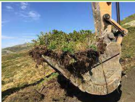
Figure 34: Prélèvement d'une plaque à la pelle mécanique (Dupin et al., 2019).
