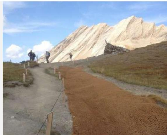
Figure 43: Mise en place d'un géotextile en toile de jute au col Agnel (hautes-alpes.net).
