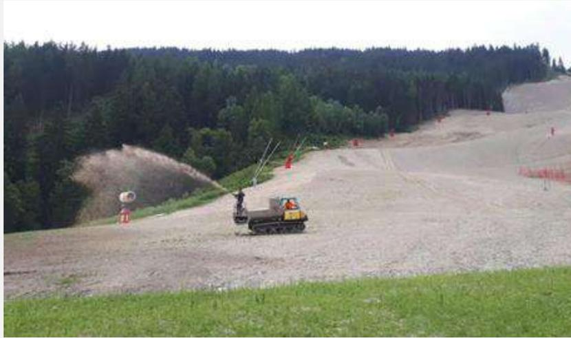
Figure 32 : Ensemencement à l'hydroseeder de la piste de l'Éclipse à Courchevel (D. Vignon, 2021)
