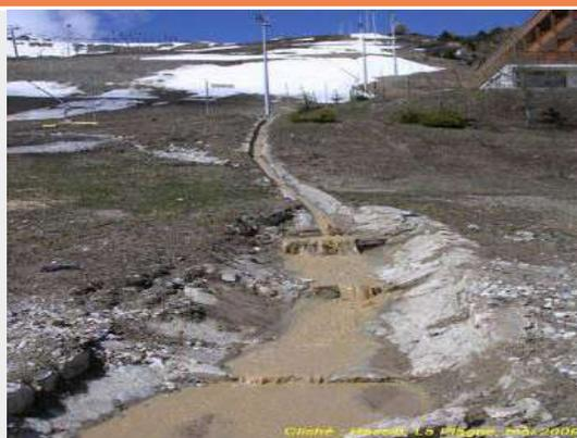
Figure 19 : Drain bétonné pour l'évacuation des eaux de ruissellement sur une piste de ski (La Plagne) (Hassid et al., 2006).
